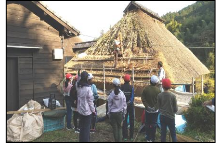
葺き替え工事の見学会
