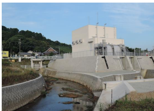
北山地区排水機場
